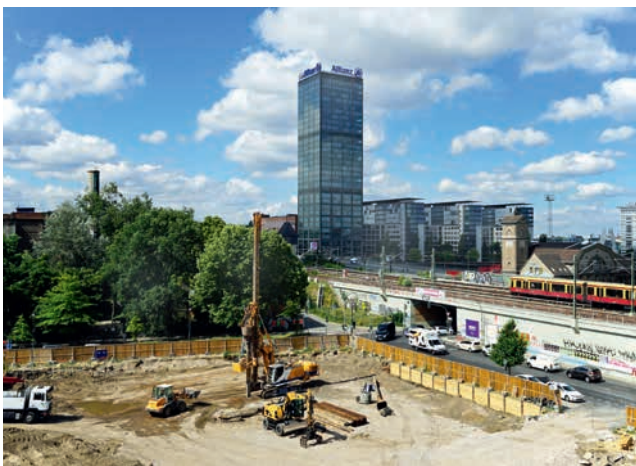
Rüttelstopfverdichtung für tragfähigen Baugrund
