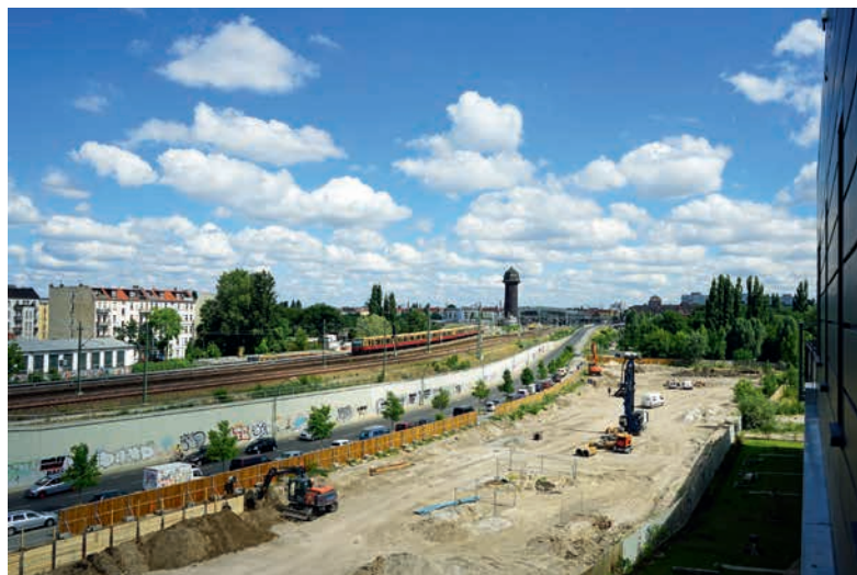
Baustelle in Richtung Bahnhof Ostkreuz
